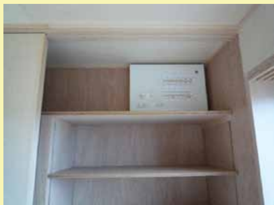
分電盤の増幅
